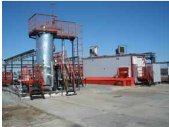
Компрессорная станция с блоками подготовки газа.
