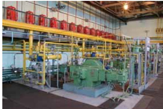
4М (оппозитная база, усилие на штоке 4тс)
