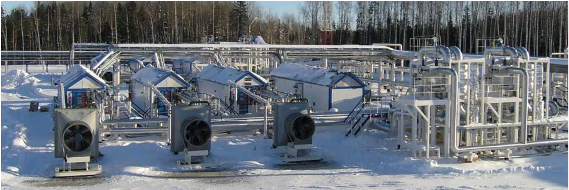
Компрессорная станция с блоками подготовки газа.
